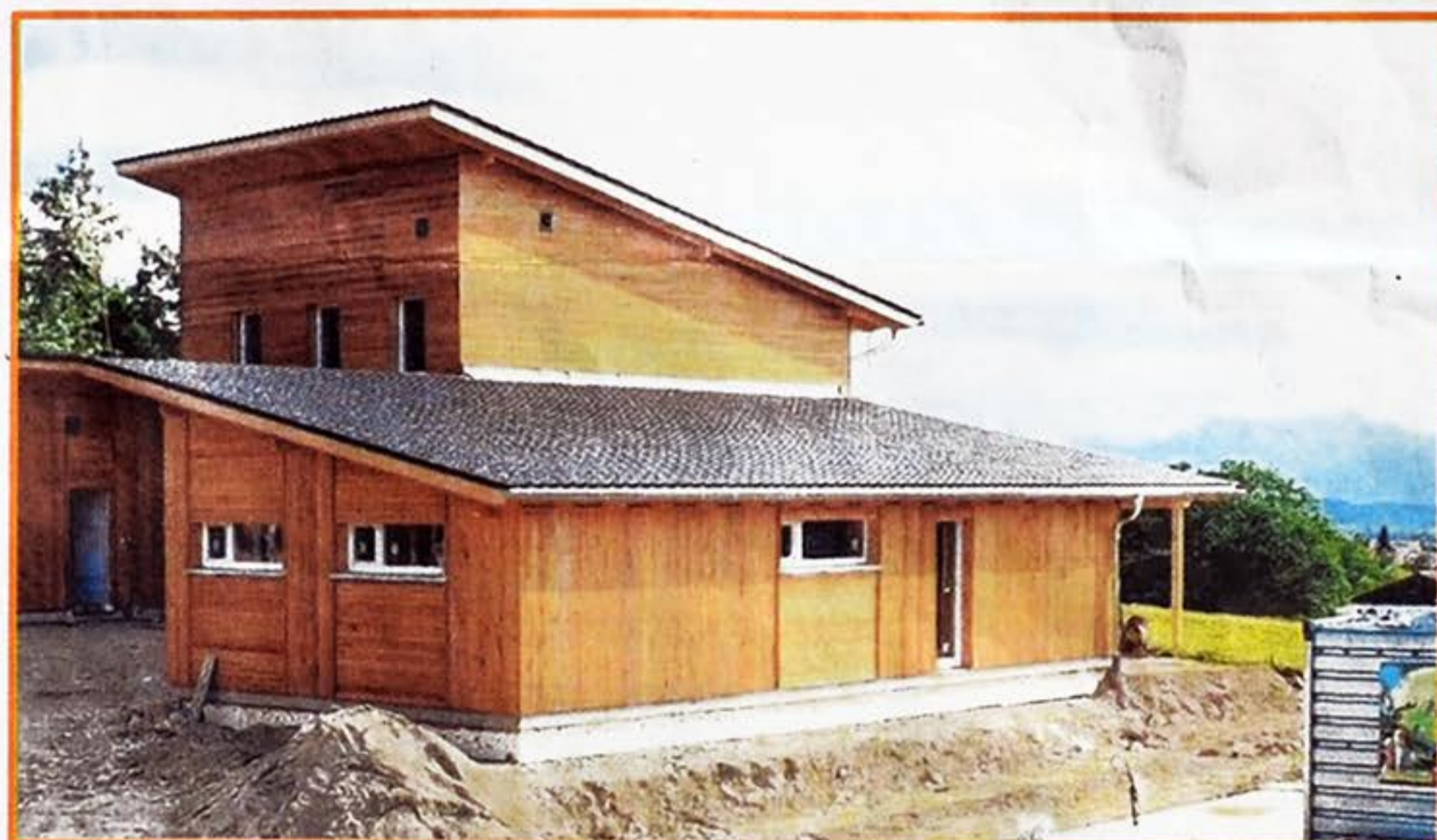
Bauherrn Hans Fritz ist wichtig: Verwendung natürlicher Baustoffe.
